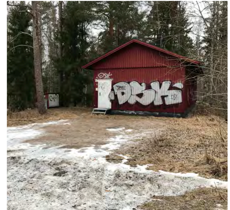
Vid Valbovägen finns idag en mindre parkering framför en tele-byggnad. Huset är idag nersprayat med graffiti och klotter.
