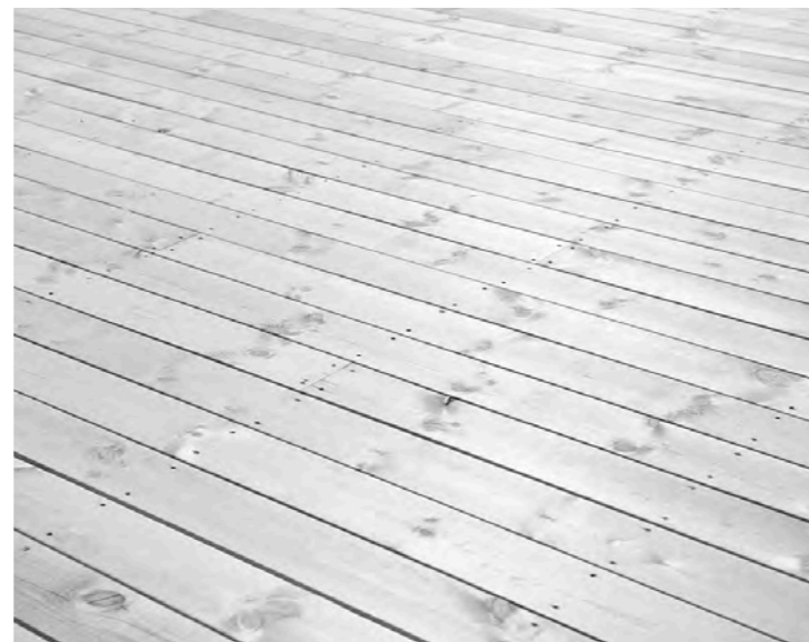
Övre: räcke i svartlackat järn. Nedre: kiseltryckt trä av furu från Organowood.
